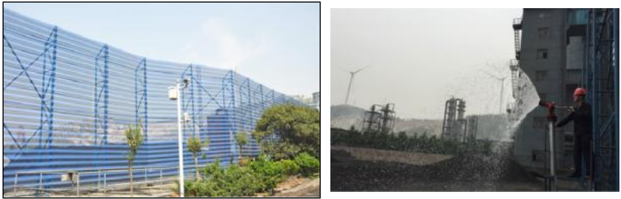
图 3.2-1 挡风抑尘网及喷淋洒水设施
