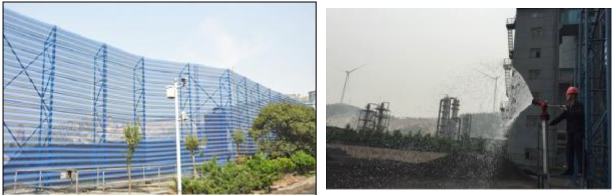
图 3.2-1 挡风抑尘网及喷淋洒水设施
