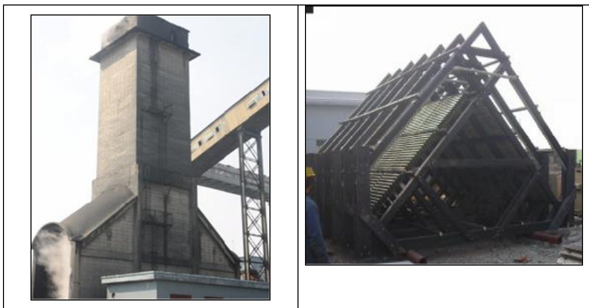
图 3.2-3 湿熄焦塔及折叠板除尘器
