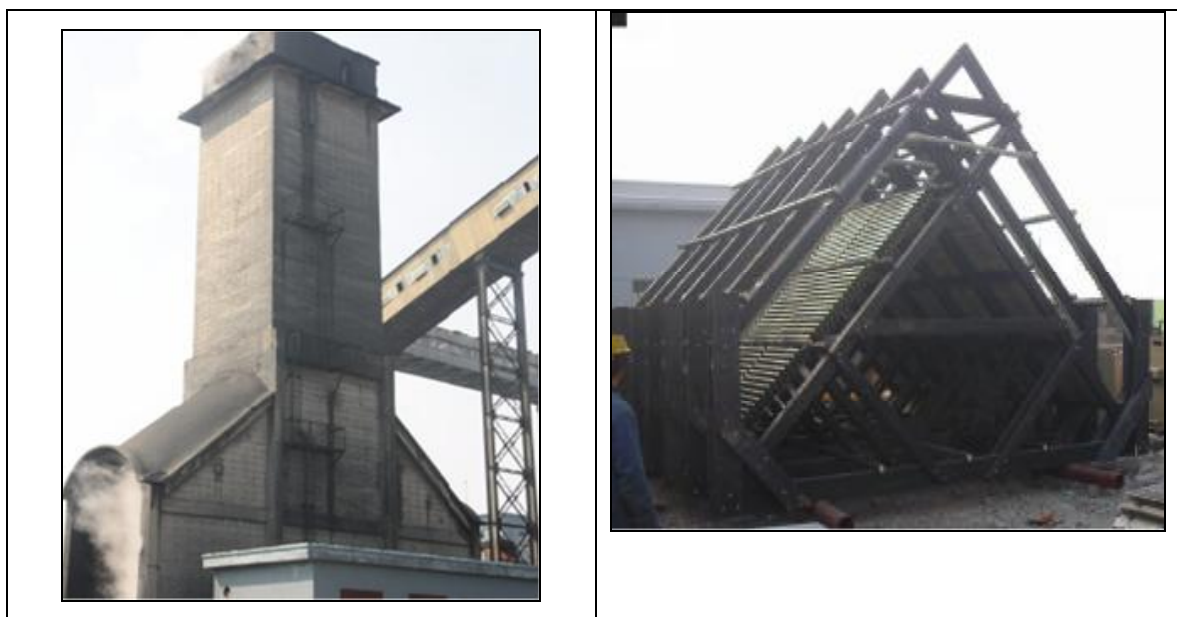
图 3.2-3 湿熄焦塔及折叠板除尘器
