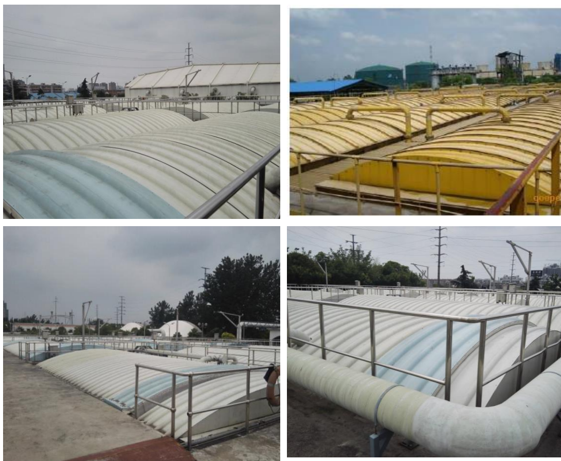
图 7.2.1-1 同类型污水处理厂装置密封示意图
