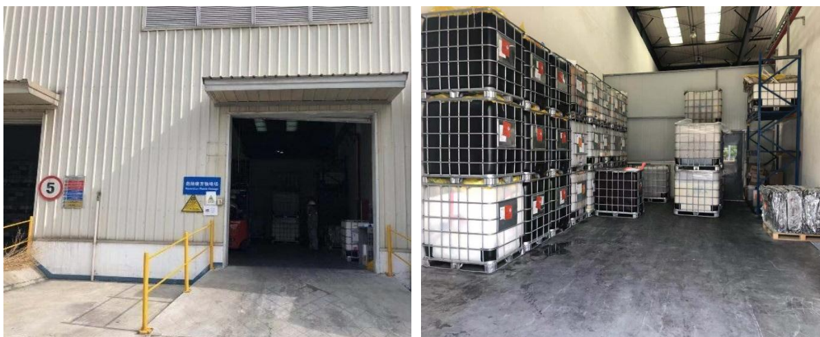
图 3.4-4 现有项目危险废物仓库照片
