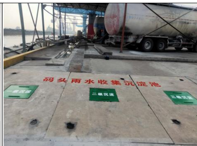
初期雨水沉淀池
