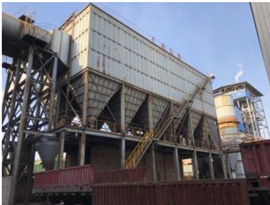
图 7.1.2-2 同类项目布袋除尘工程实例图
