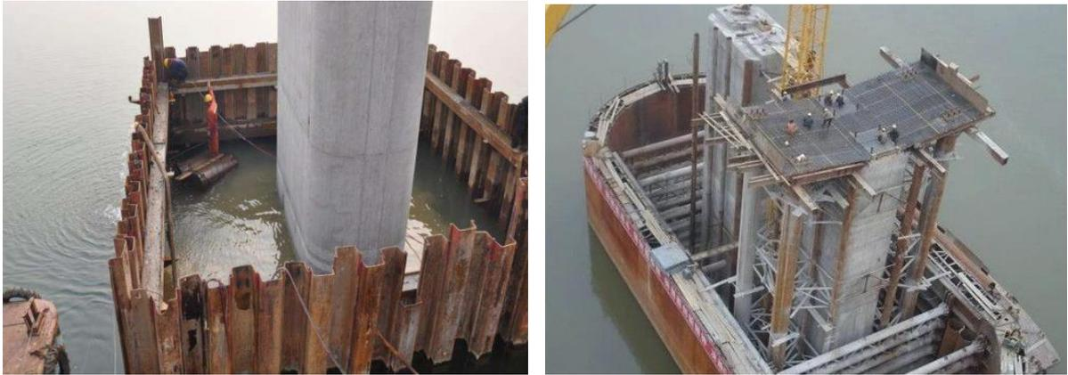
图 8.3-1 钢围堰施工现场图
