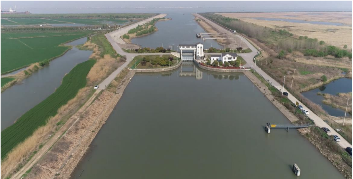
图 3.2-2 新福山闸现状照片
