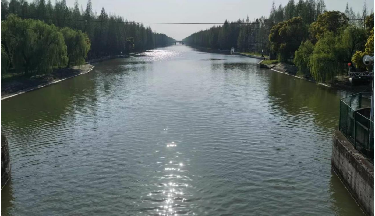
图 3.1-1 北福山塘（福山闸内侧）河道现状
