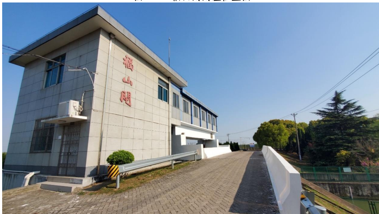
图 3.1-2 老福山闸（1998 年建）
