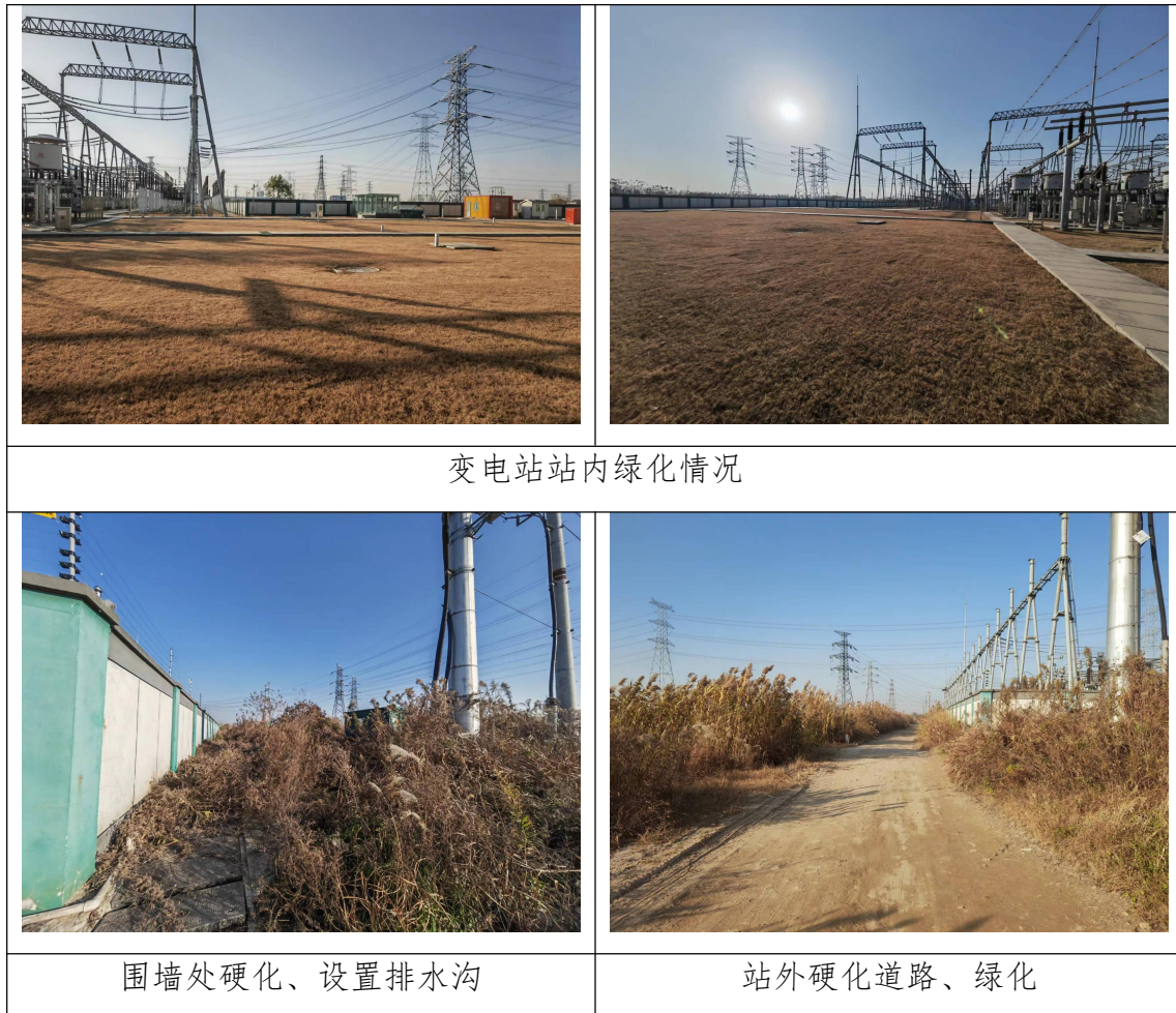
图 3.8 变电站采取生态保护措施
