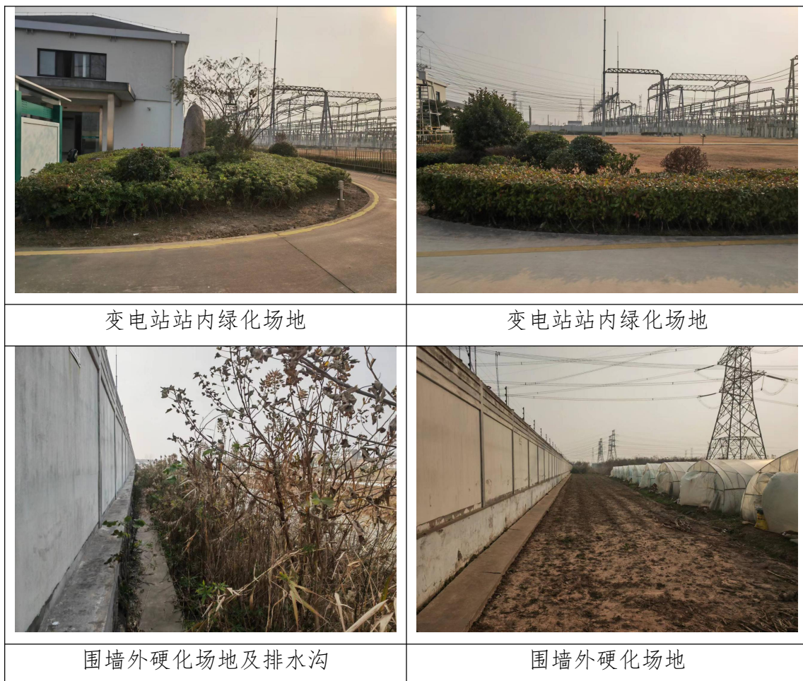
图 3.15 变电站采取生态防治措施
