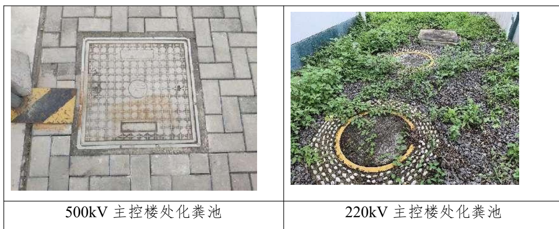
图 3.7 变电站原有化粪池情况
