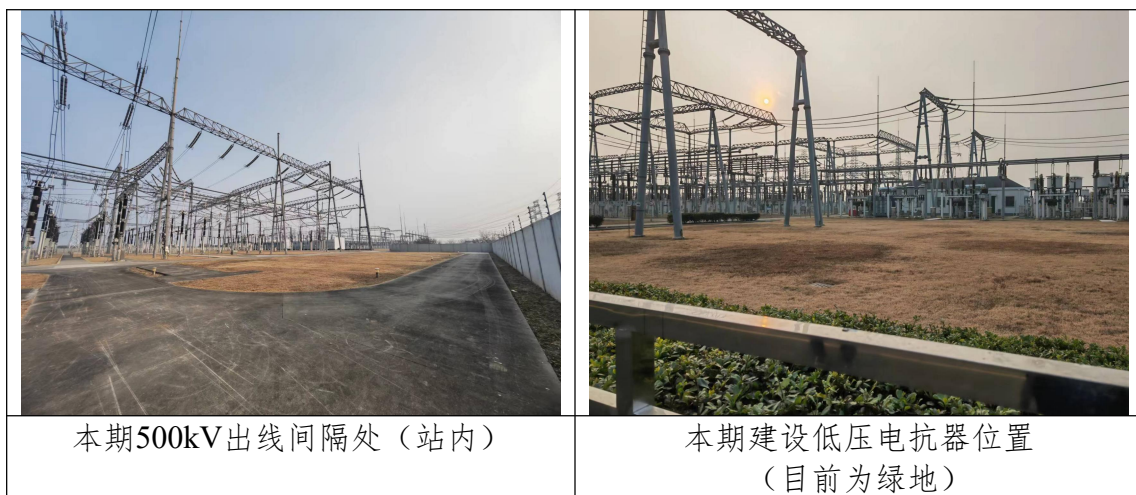
图3.11 东洲500kV变电站间隔扩建项目的场地周围情况
