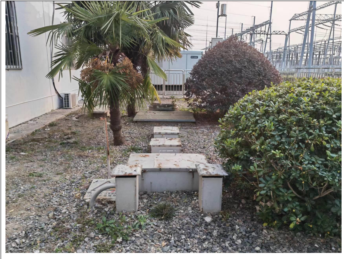
图 3.17 变电站原有地埋式污水处理装置
