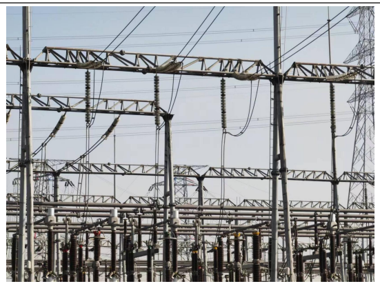
220kV 配电装置 (AIS)
