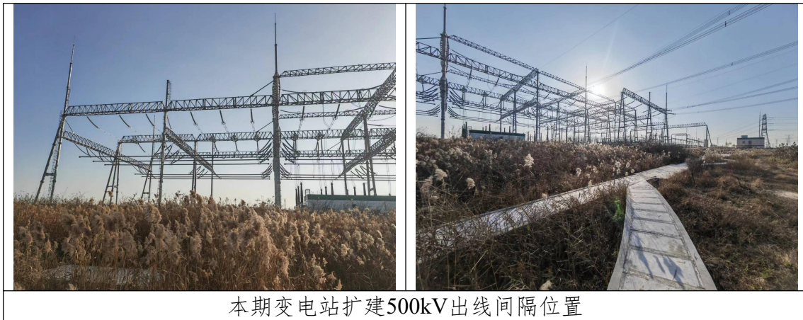
图3.4 新丰500kV变电站出线间隔扩建场地情况
