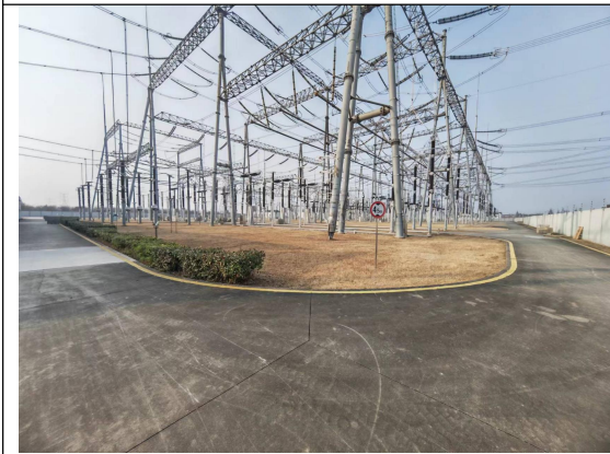
500kV 配电装置 (AIS)
