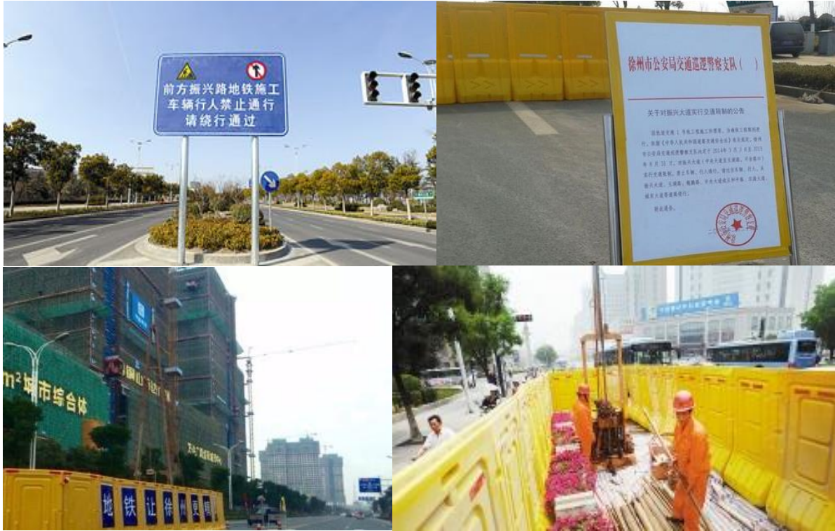
图 11.3.3-1 徐州市轨道交通 1 号线施工现场交通疏导及围挡
