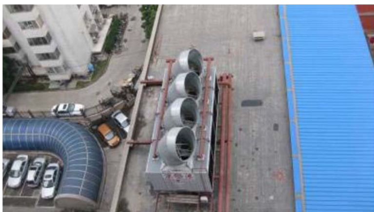
图 4.4-1 冷却塔导向消声器实施实例
