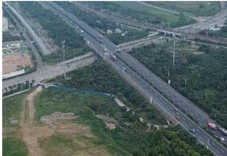
图 5-6 撤洪沟航拍图
