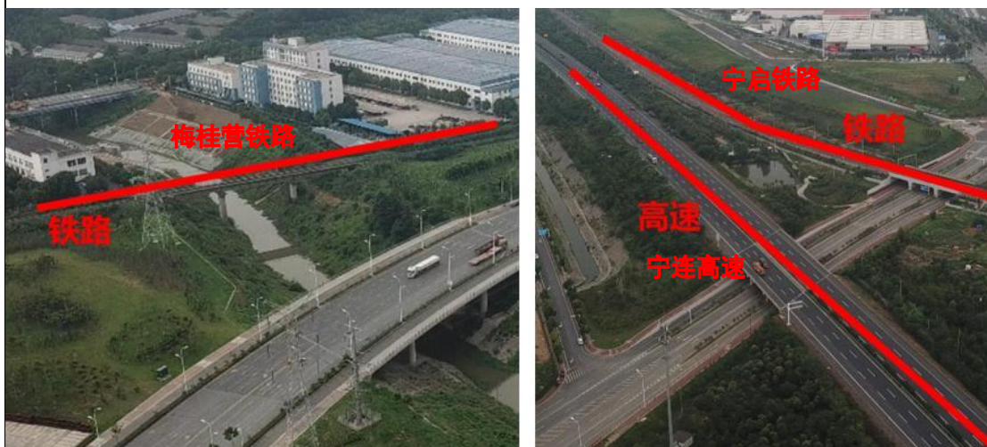
图 5-7 沿线影响建筑物航拍图
