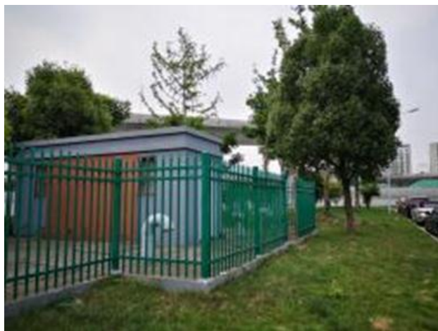
图 1-5 高新污水处理厂现状 1#污水泵站（配电室）
