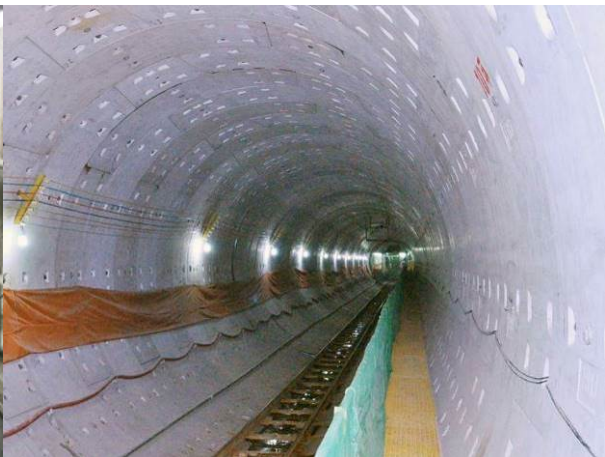
盾构法隧道施工现场（建成后）
