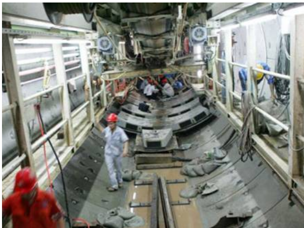
盾构法隧道内部施工现场
