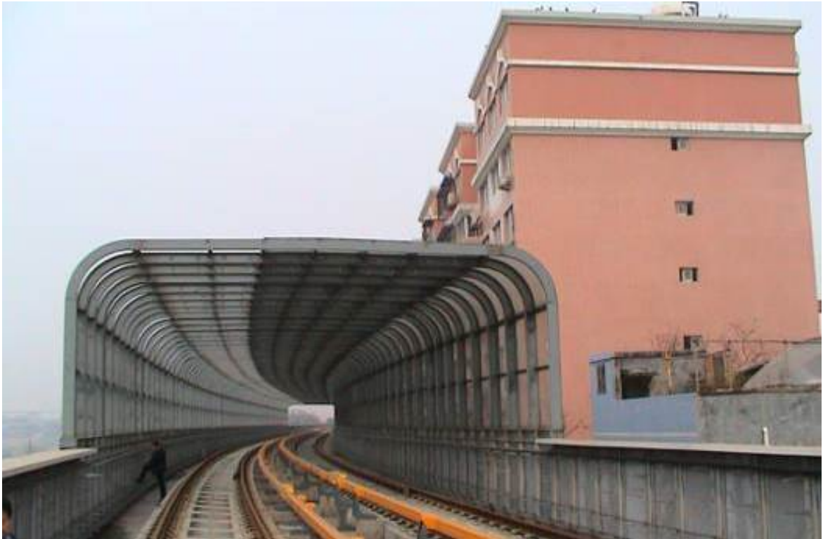
图 5.1-3 大型折板式（半封闭）声屏障示意图
