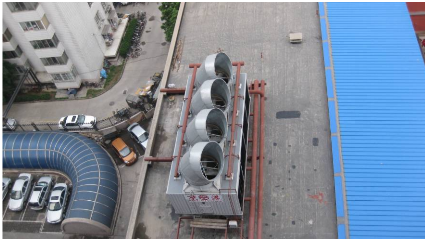
图 5.1-1 冷却塔导向消声器实施实例
