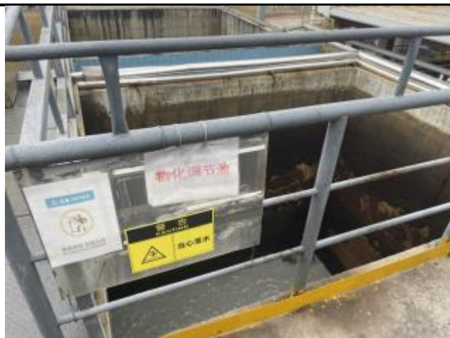
物化线（车间生产废水）-物化调节池
