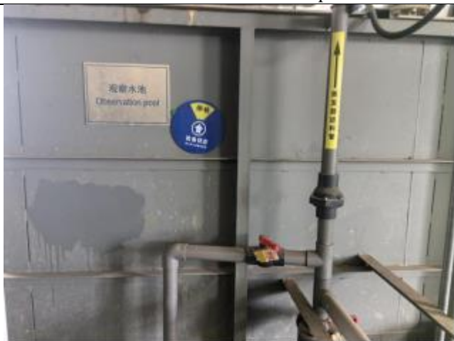
物化线（废切削液清洗废水）-观察水池
