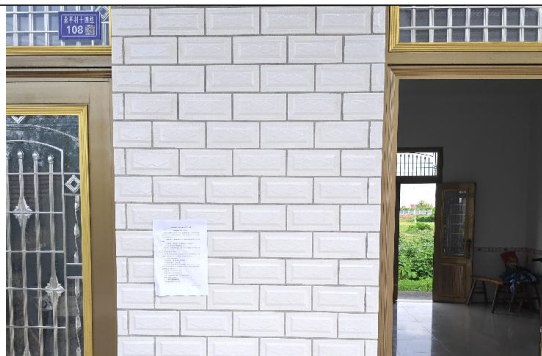
永平村 14 组 108 号民房门口（近）
