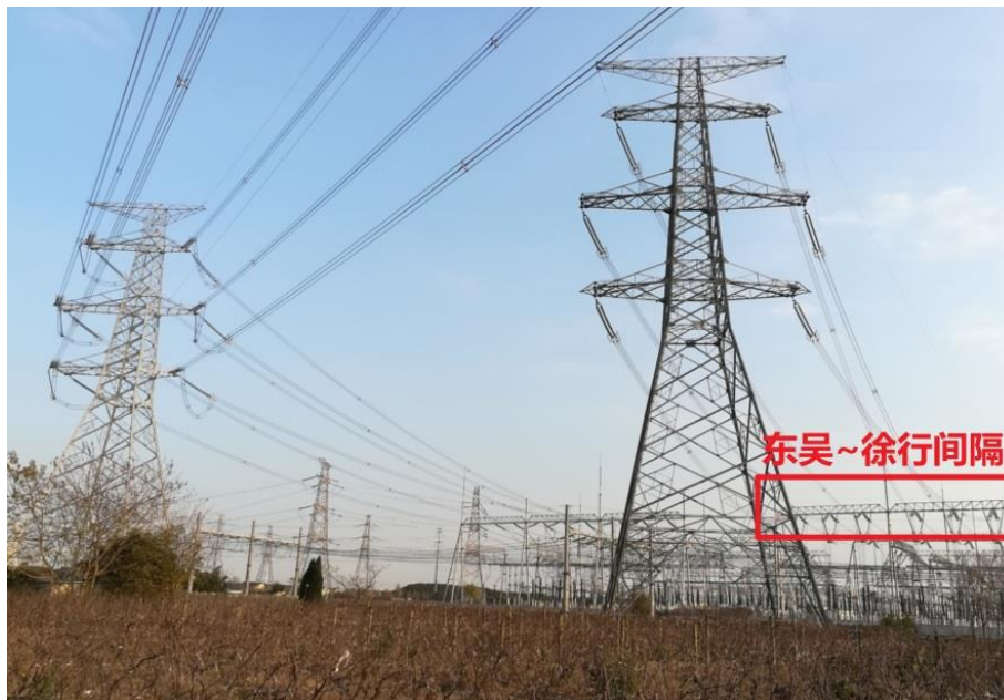
图 3.1-18 改接至东吴出线间隔照片
